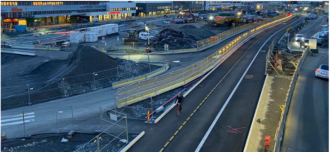
Underveis på Minde: Deler av E39 sykkelstamveg Kristianborg–Bergen sentrum (langs Bybanen BT4) er tatt i bruk. Foto: Bybanen utbygging
