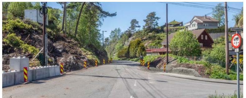
Under utbygging: Nytt gangfelt og fortau i kryss Mildevegen. Foto: Silje Drevdal
